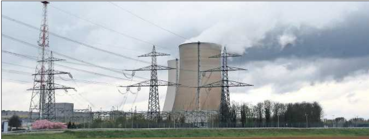
Block I des Kernkraftwerks ist seit 2011 abgeschaltet, Block II soll bis Ende 2019 laufen.
